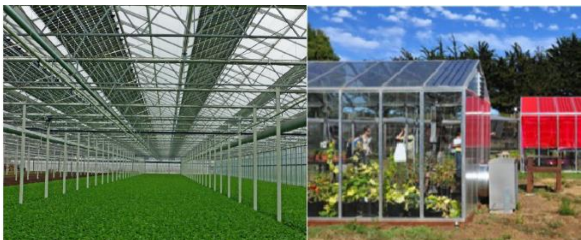
شکل ۸- نمایی از گلخانه‌های مجهز به سیستم فوتولتائیک پلیمری شفاف [۲۷، ۲۸].
