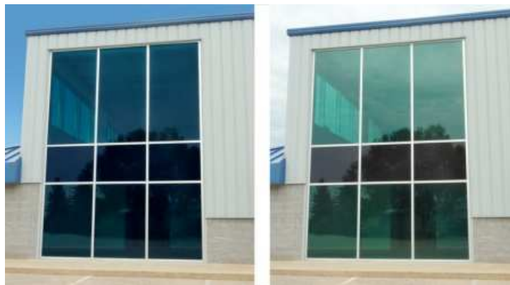
شکل ۶- نمونه‌ای از کاربرد ترموکروم معدنی در شیشه‌های هوشمند تجاری.
