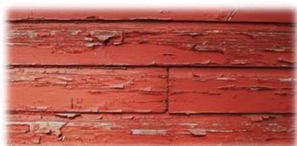
شکل ۳- تصویر چوب‌های رنگ‌آمیزی شده پس از هوازدگی [۱۴].
