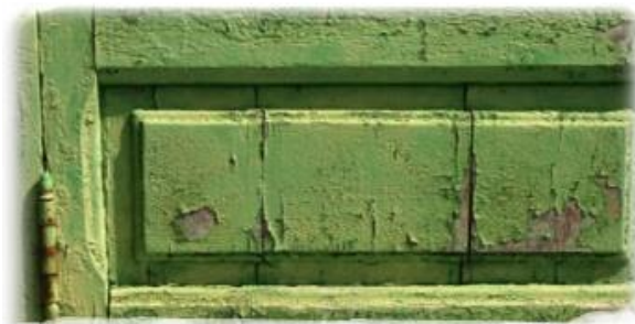
شکل ۳- تصویر چوب‌های رنگ‌آمیزی شده پس از هوازدگی [۱۴].
